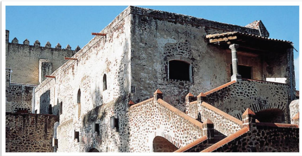
Foto 29. Ex Hacienda San Antonio Acolman, locación del Viva Glam XII. Ubicada en el Estado de México. Foto. Archivo Personal.
