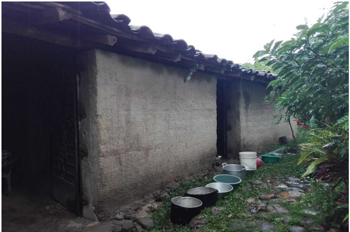
Ilustración 12, abasteciendo de agua lluvia uno de los hogares de Yancolo
