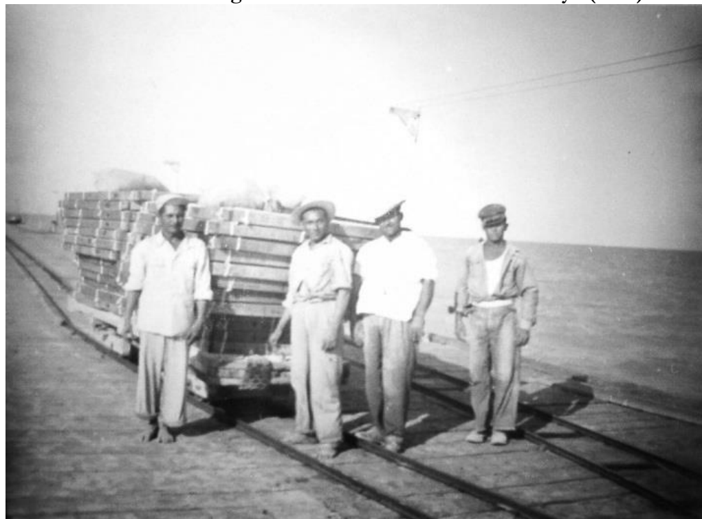
Imagen 14 Maniobras de carga de madera en el muelle de El Cuyo (1960)
