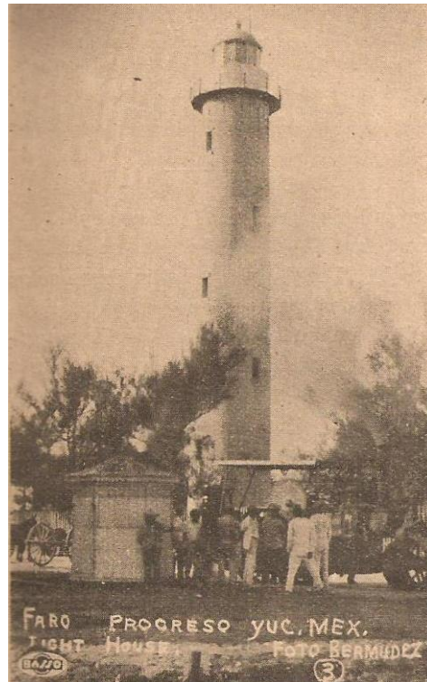
El faro, Progreso, Yucatán.
