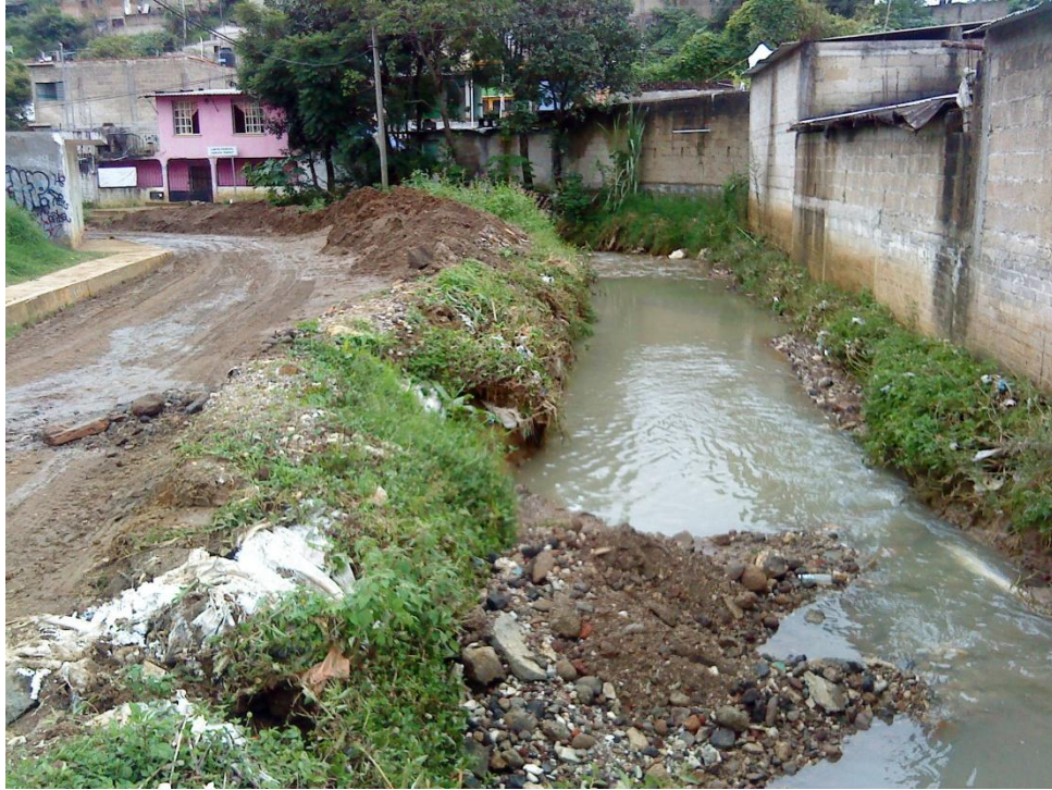
Fig. 2.4: El Arroyo Papas y las construcciones a sus orillas
