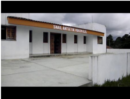
Imagen No. 6 Exterior casa materna
