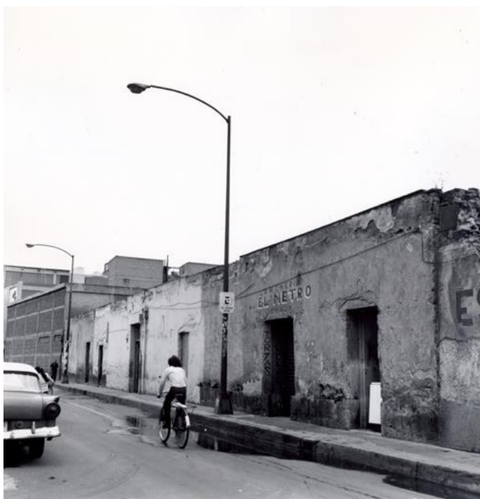
Una parte importante de los habitantes de los alrededores de la plaza San Juan fueron beneficiados con vivienda nueva tras el sismo de 1985. Destaca el nombre del negocio de la vecindad: “El Metro”. Fecha: ca. 1974. Fuente: Fototeca Constantino Reyes Valerio.
