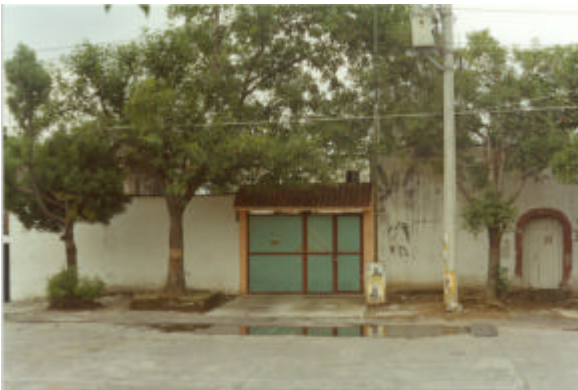
“Viejas paredes destruidas, que si tuvieran vida nos hablarían también”. Estado actual del edificio que hasta la década de los cuarenta albergara la escuela primaria “La Fama Montañesa. Barrio La Fama. Delegación Tlalpan. Septiembre de 2000
