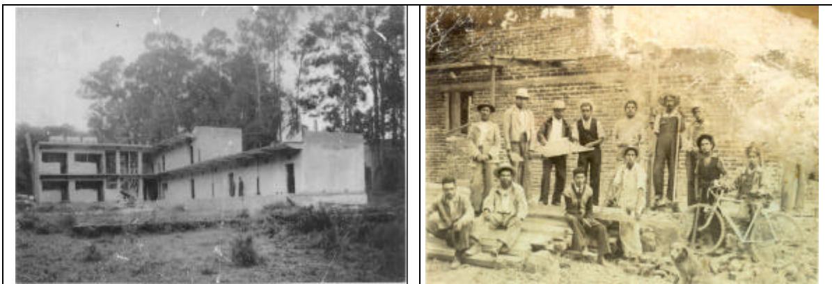
Izq. “Escuela “José Azueta” C.a 1942. Fuentes Brotantes. Tlalpan. México DF. Foto archivo escolar. Der. El director de la escuela, el profesor de carpintería y los obreros frente a la obra del edificio escolar. Foto archivo personal Sra. Tomasa Torres Reyes
