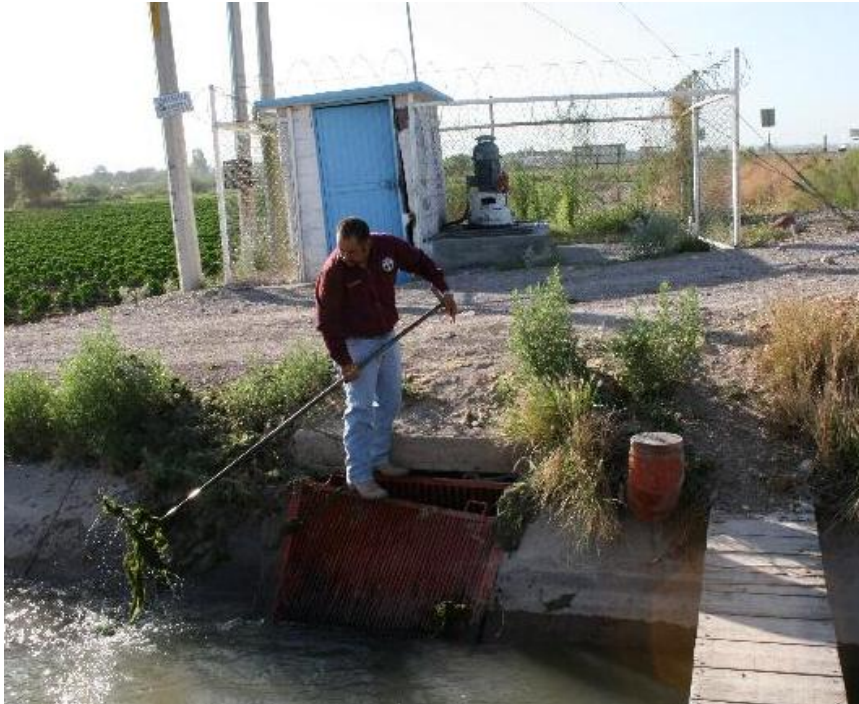
Figura II.1.15. Canalero limpiando un cárcamo
