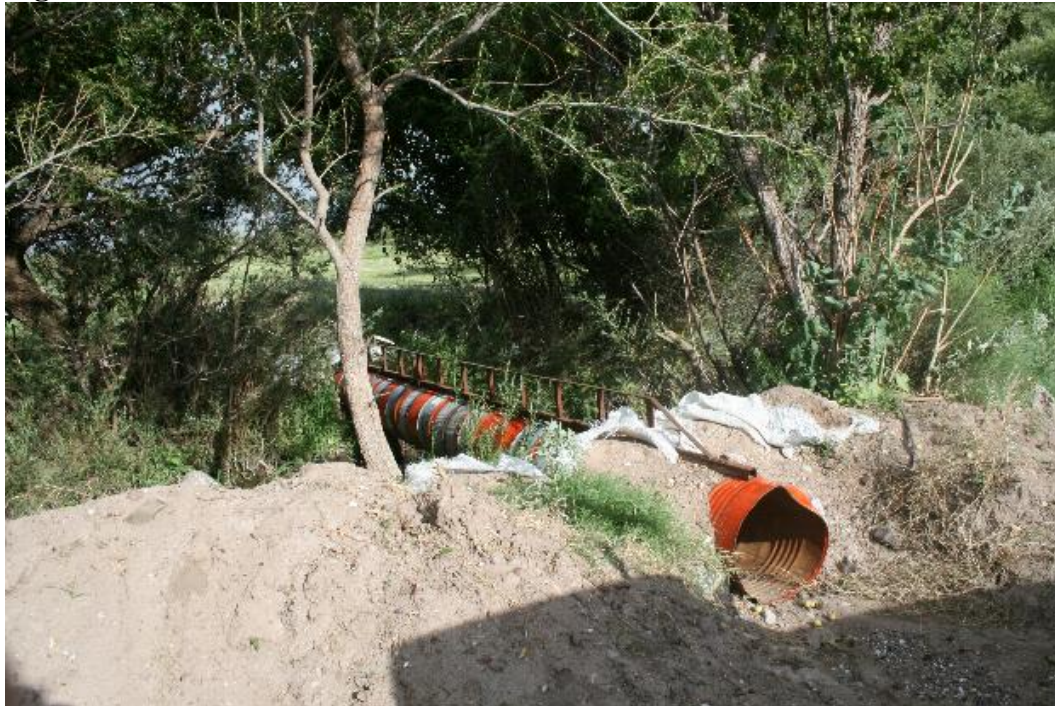
Figura II.1.23. Cruce de un sifón hecho con tambos
