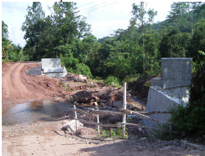
Foto 1 Bases del puente a la entrada de San Lucas
