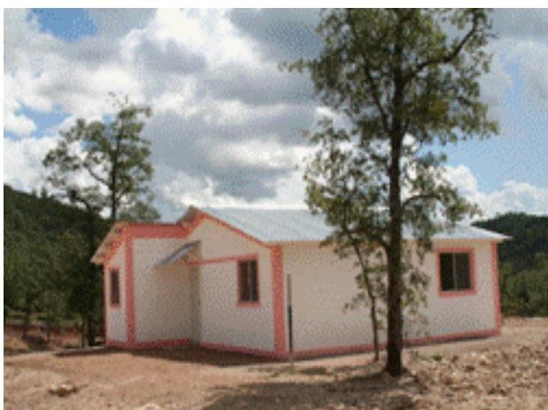
Las nuevas construcciones de Dolores
