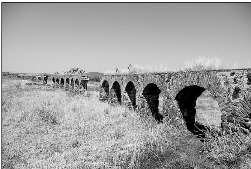
Figura 2.- Acueducto del drenaje del río Cocula. Fuente: Archivo Personal Andrés González Robles, 2010.
