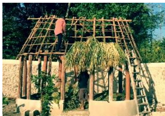
Figura 4. VIDEO 2. Construcción de una casa
