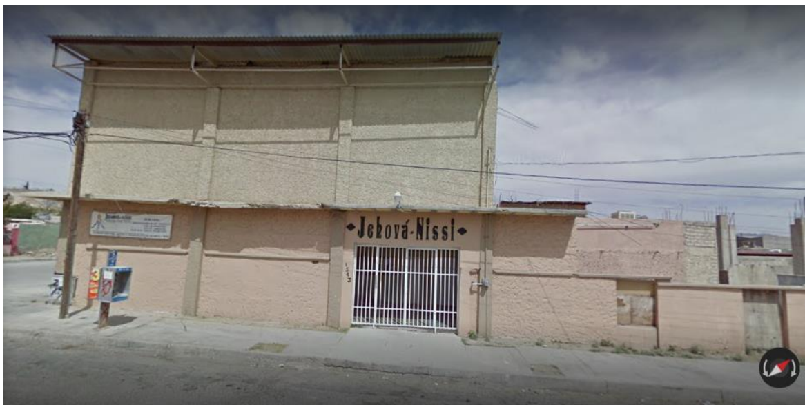
Fachada principal del templo Jehová Nissi. El edificio está en proceso de ampliación como se puede apreciar a mano derecha.
