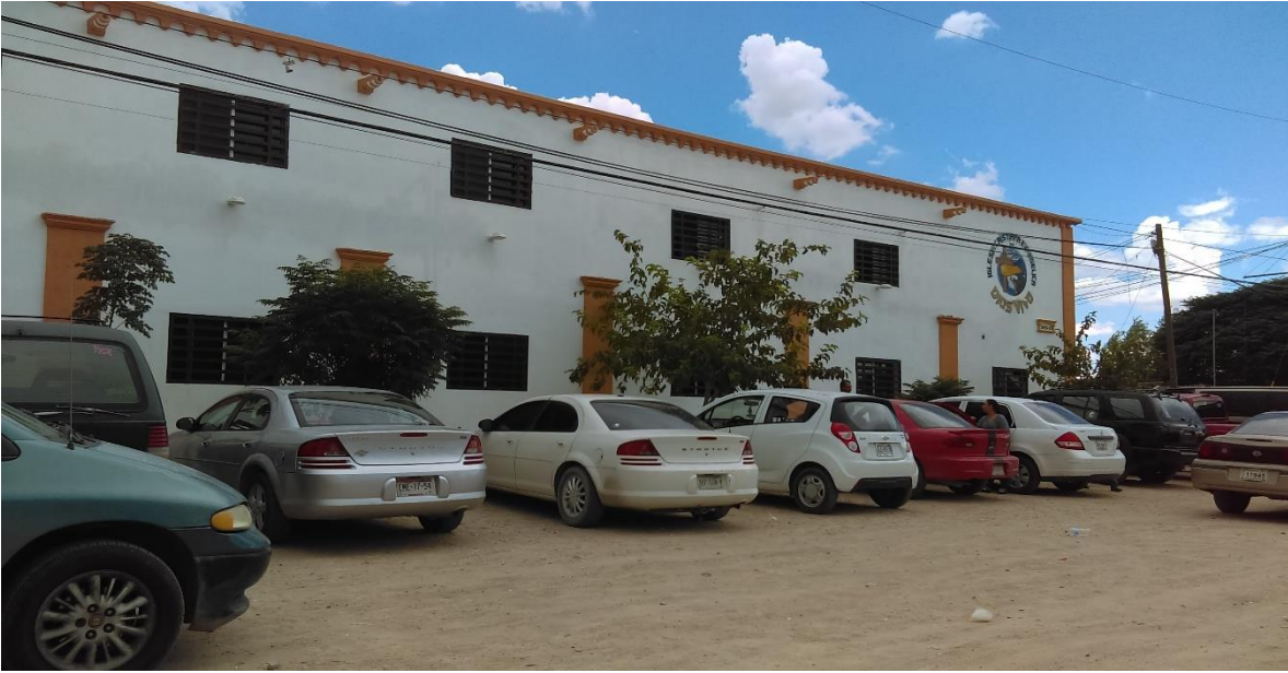
Fachada principal del templo Dios vivo. La estructura del edificio es un galerón de dos plantas
