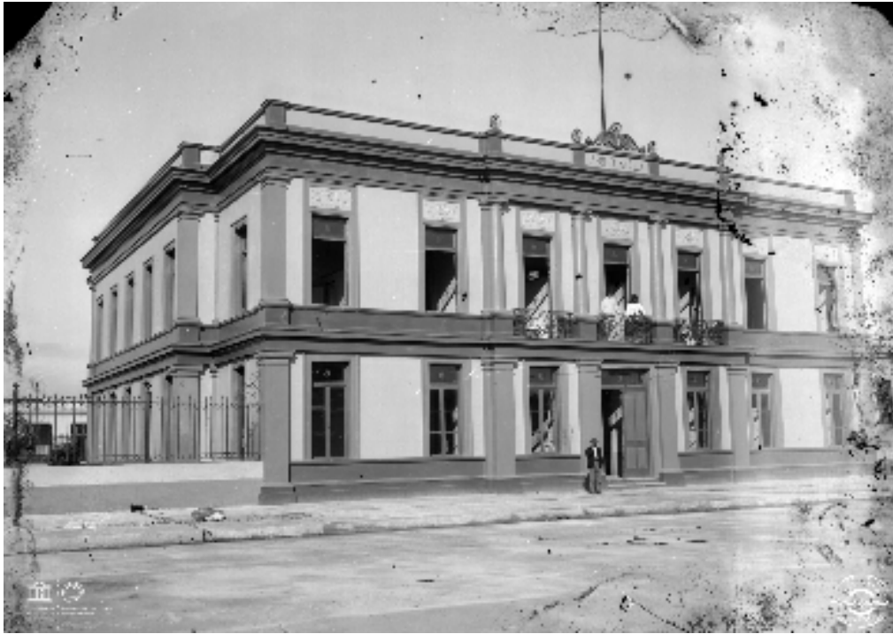
Imagen 1.- Fachada exterior del Asilo Ayala, Fotografía Guerra, Ca 1910. 48
