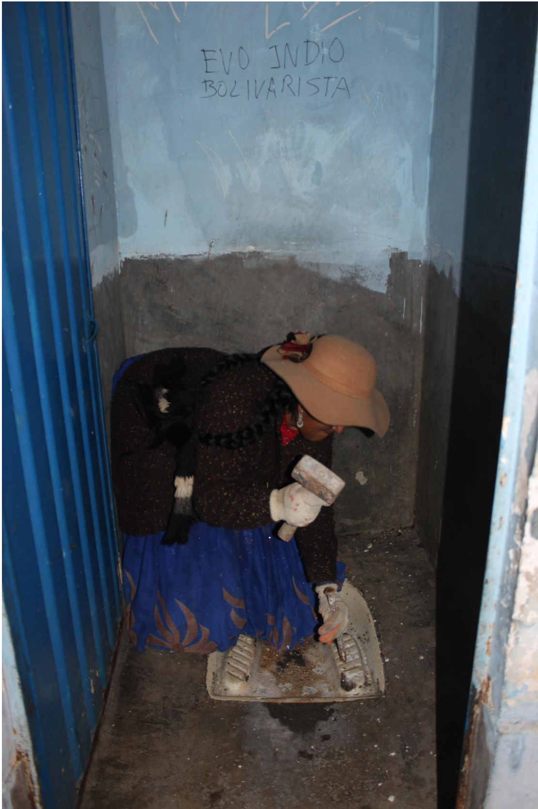
Ilustración 26 Marta, maestra constructora, arregla el baño del Mercado. En la pared se lee "EVO INDIO BOLIVARISTA". Pasankeri. La Paz. 13-5-19.
