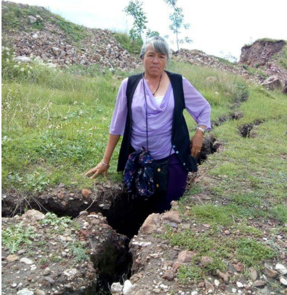
Ilustración 14. La señora Angélica M. González al interior de una de las fracturas del suelo provocadas por los trabajos de explosión de la mina detrás de su casa. Fuente: Archivo personal de Angélica María González.
