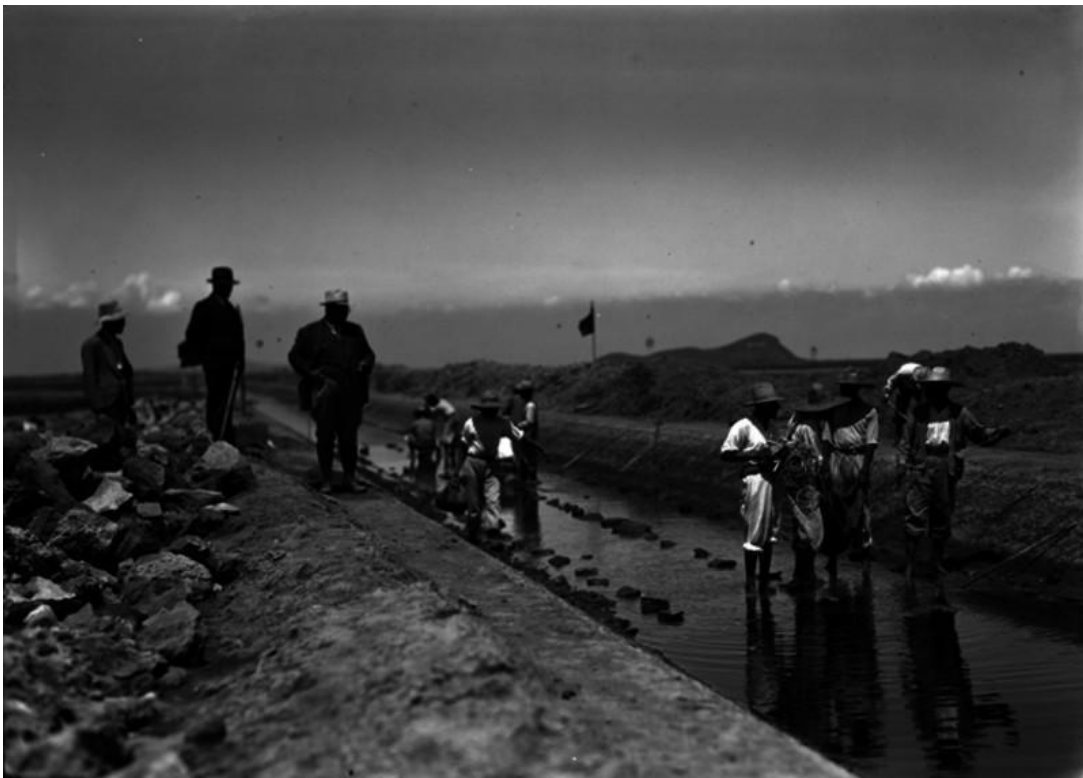
Ilustración 9. Tres hombres, los ingenieros, vestidos de traje y botas observan a una decena de trabajadores manipulando los explosivos para el desazolve del canal en el Lago de Texcoco, 1938. Fuente: Archivo Casasola
