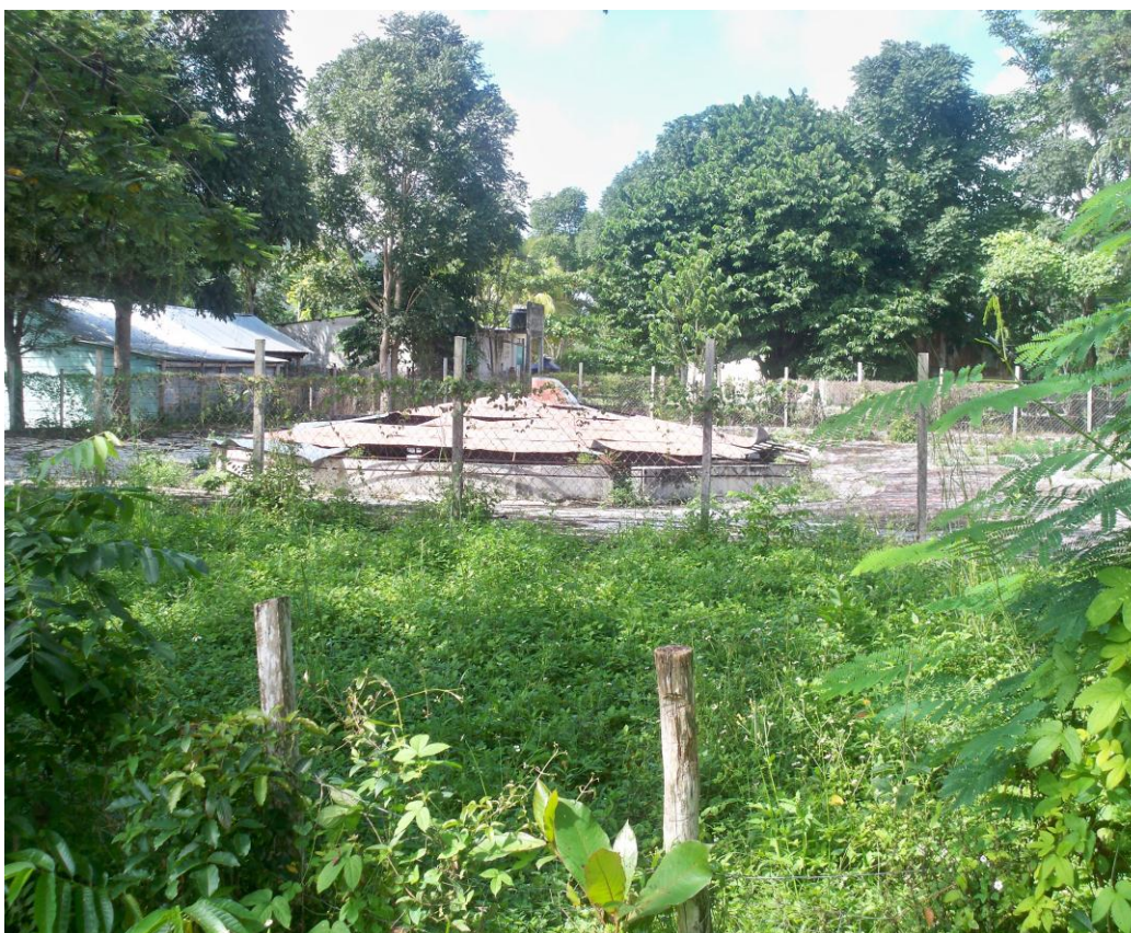
Ilustración 7 Colector de agua ejidal
