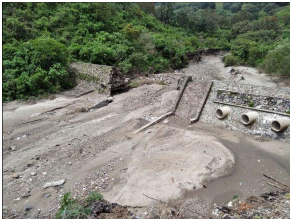
Figura I.2. Daños en uno de los cuatro gaviones del arroyo Seco en bosque La Primavera
