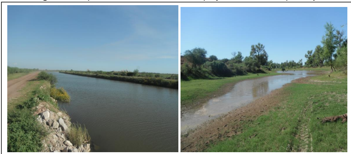
Figura 1. Aspecto del cauce del río Yaqui y el Canal Principal Bajo
