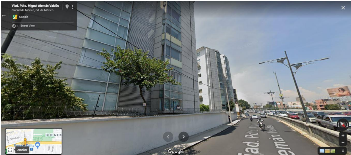
Imagen A: Esta unidad habitacional en el área colindante del corredor con Viaducto Miguel Alemán cuenta con cuatro elementos en su sistema de seguridad: cercas electrificadas en todo su contorno, concertinas de púas, así como cámaras de seguridad y vigilancia privada
