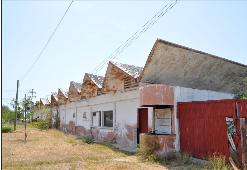
Fotografía 28. Planta congeladora abandonada Impulsora marítima. Fuente: elaboración propia, 2022.
