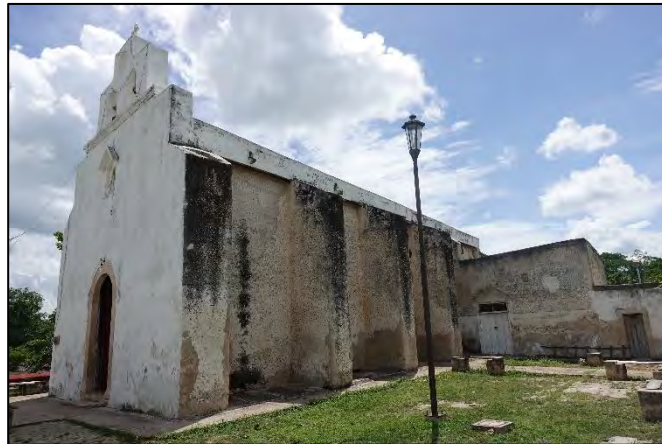
Imagen 3.8 Capilla u oratorio de la hacienda Xcabil (fotografía del autor).
