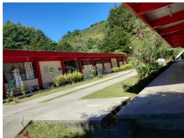
Figura 10. Actuales aulas del Plantel 41 Totontepec. Archivo personal. Enero 2024.
