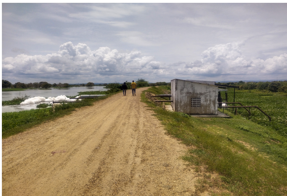
Ilustración 9. Caseta de bombeo de aguas a un lado del terraplén
