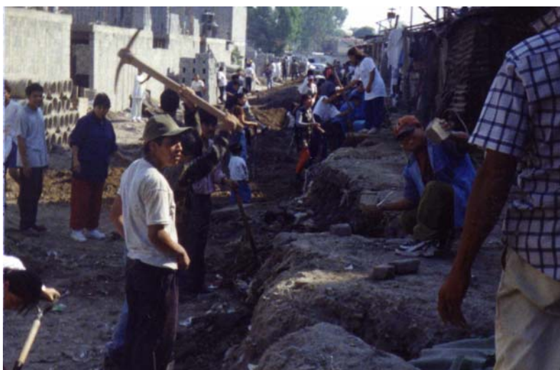
Construcción de la Unidad Habitacional Fase II. Archivo Asociación Frente Renovación
