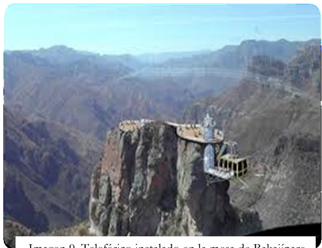
Imagen 9. Teleférico instalado en la mesa de Bakajípare
