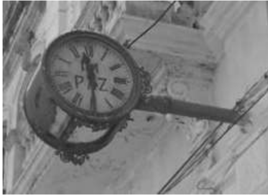
En la fotografía del autor se observan los restos corroídos del reloj “La Paz” sobre el hidrante Kennedy.
