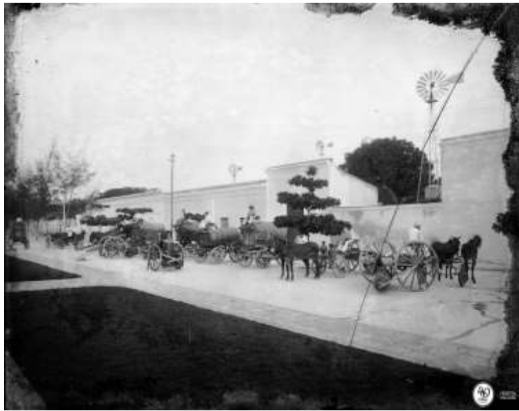
Un ejemplo de los equipos de riego y barrido de las calles reproducido con permiso de la Fototeca Pedro Guerra de la Facultad de Ciencias Antropológicas de la UADY, “Equipo de limpieza del ayuntamiento hacia 1930ca., integrado por carretas para riego y carretas barredoras que tenían adaptado un cepillo giratorio en la parte trasera, ambas eran tiradas por mulas”. Calle 47 x 58 y 60 Centro Fondo Pedro Guerra, 3°. - Clave digital 2A08168.jpg, Soporte Negativo de vidrio placa seca (gelatina), blanco y negro 20.3x25.3 cm; 8 x 10 pulgadas.
