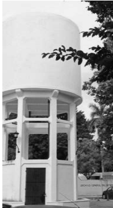
Fotografía del autor de la cisterna del hospital O'Horan, se observa el letrero del Archivo General del Estado de Yucatán.
