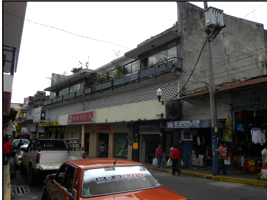
8. Uno de los hoteles (planta alta del edificio) donde se hospedan los ixhuatecos de residencia semi-permanente y esporádica en Xalapa.
