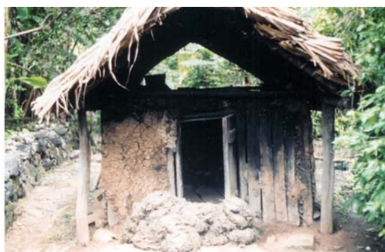
Construcción de un temascal o pus
