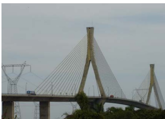
Ilustración 1-4 Puente Coatzacoalcos II. Municipio Coatzacoalcos, 2005.
