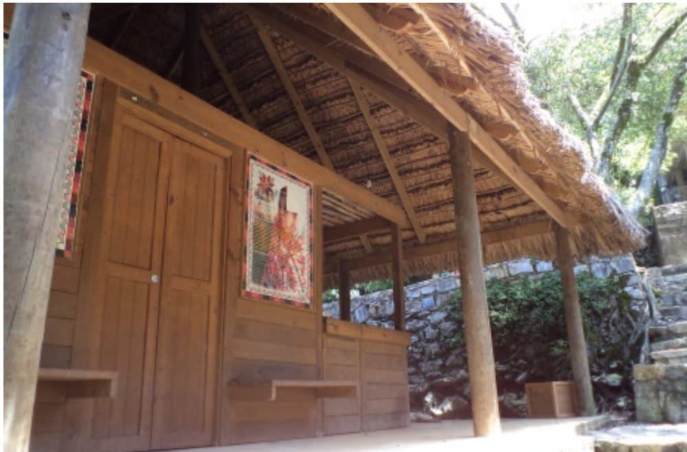
Ilustración 13. Caseta de cobro Sótano de las Huahuas
