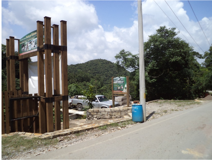
Ilustración 12. Estacionamiento Sótano de las Huahuas
