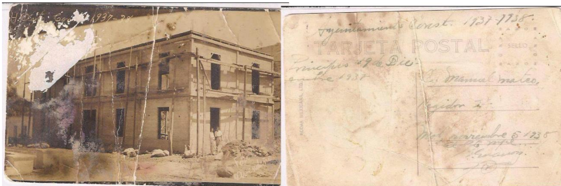
Foto 8. Fotografía fechada el 19 de diciembre de 1937, los inicios de la construcción de la presidencia. Atrás de la foto se lee: “Ayuntamiento Const. 1937-1938. Principio 19 de Diciembre de 1937. C. Samuel Mateo Regidor 2º”. Fuente: Archivo privado de la familia Mateo, Motozintla de Mendoza, Chiapas.
