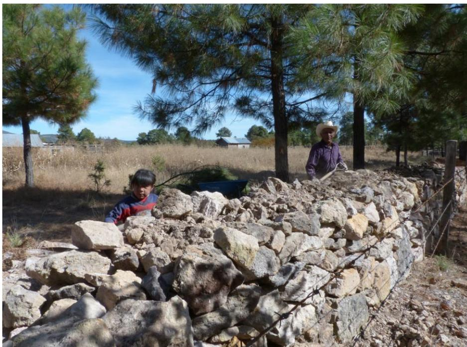
**Fig. 11** Construcción de trincheras de piedra, en la comunidad de Pitorreal.
