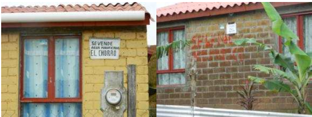
Foto 43 y 44. Pequeñas actividades comerciales en las viviendas.
